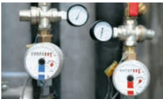
Тахометрические счётчики горячей и холодной воды: внешний вид
