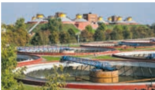
Очистные сооружения Люберецкой водоочистительной станции
