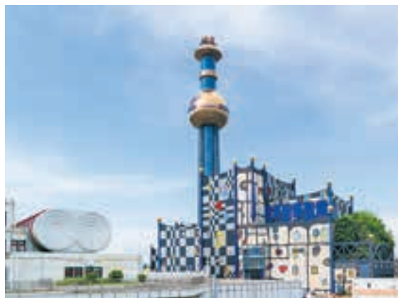
Современный мусоросжигательный завод в Вене является достопримечательностью города
